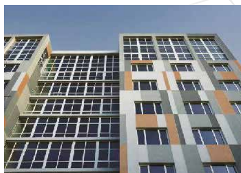
БЦ Park Tower м. Київ
