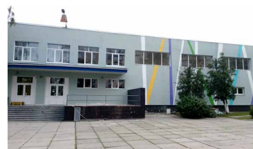
Реконструкція школи 210 м. Київ
